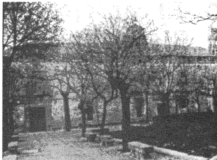
entrada al antiguo convento.
